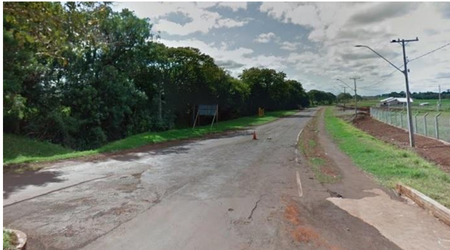
Figura 2 – Situação atual da pista de caminhada e falta de segurança Foto: autores, 2017.
