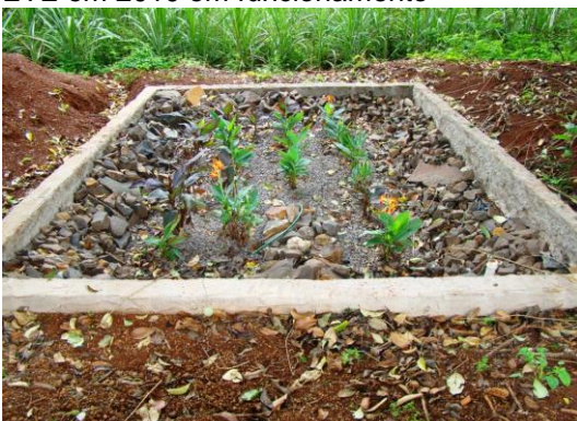
ETE em 2010 em funcionamento
