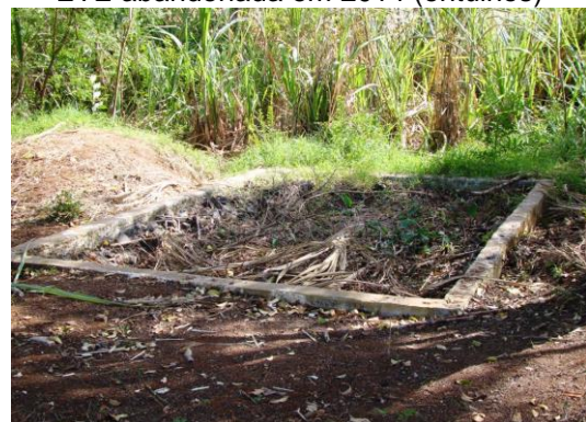
ETE abandonada em 2014 (palhada)
