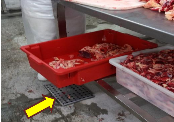
FIGURA 6 - Escoamento de água
