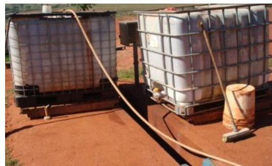
FIGURA 7 – Adição de PAC e PC e medidor de vazão.
